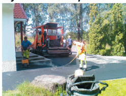
Ny asfalt ved kapellet
